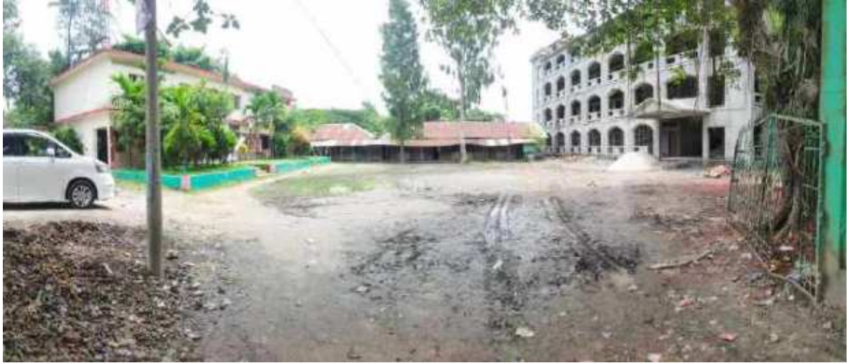
চিত্র ৭.২০: মনোহরগঞ্জের সাইকচাইল সরকারি প্রাথমিক বিদ্যালয়ের বিদ্যমান অবস্থা
