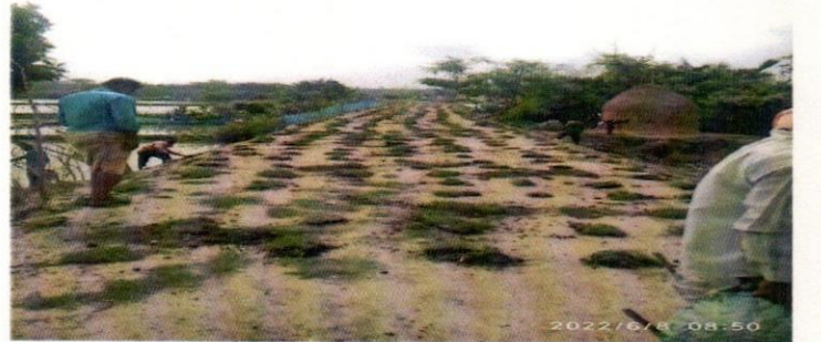
কিমের নামঃ জাবুসা বেড়ীবাঁধ, (টার্ফিং কাজ চলমান অবস্থা), উপ-প্রকল্পের নামঃ জাবুসা উপ-প্রকল্প (এস পি নং- ১২০২৭), উপজেলাঃ রূপসা, জেলাঃ খুলনা
