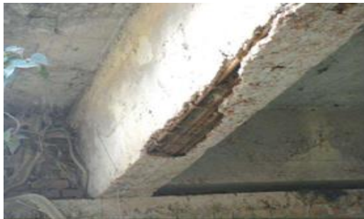
SD1. Spalling
